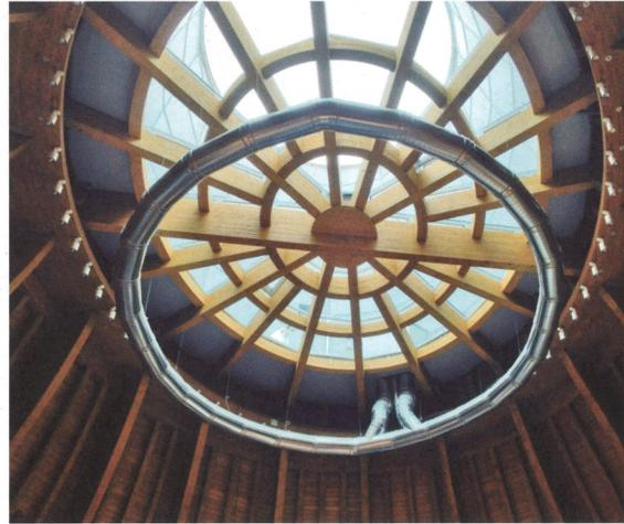
*Posa e ultimazione del grande camino solare che racchiude 1.200 m<sup>2</sup> di serpentine per il riscaldamento dell'acqua calda sanitaria, oltre a provvedere al ricircolo naturale dell'aria interna.*
